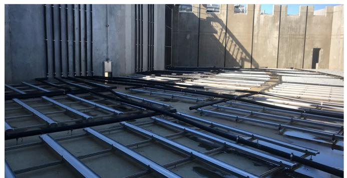
wartet, erhielt der örtliche AEROSTRIP®-Partner den Zuschlag: Für die vier ringförmigen Becken wurden insgesamt 1.712 AEROSTRIP®s der Type Q4,0 geliefert und installiert.
